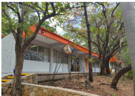
Trabajos de pintura en el edificio F
