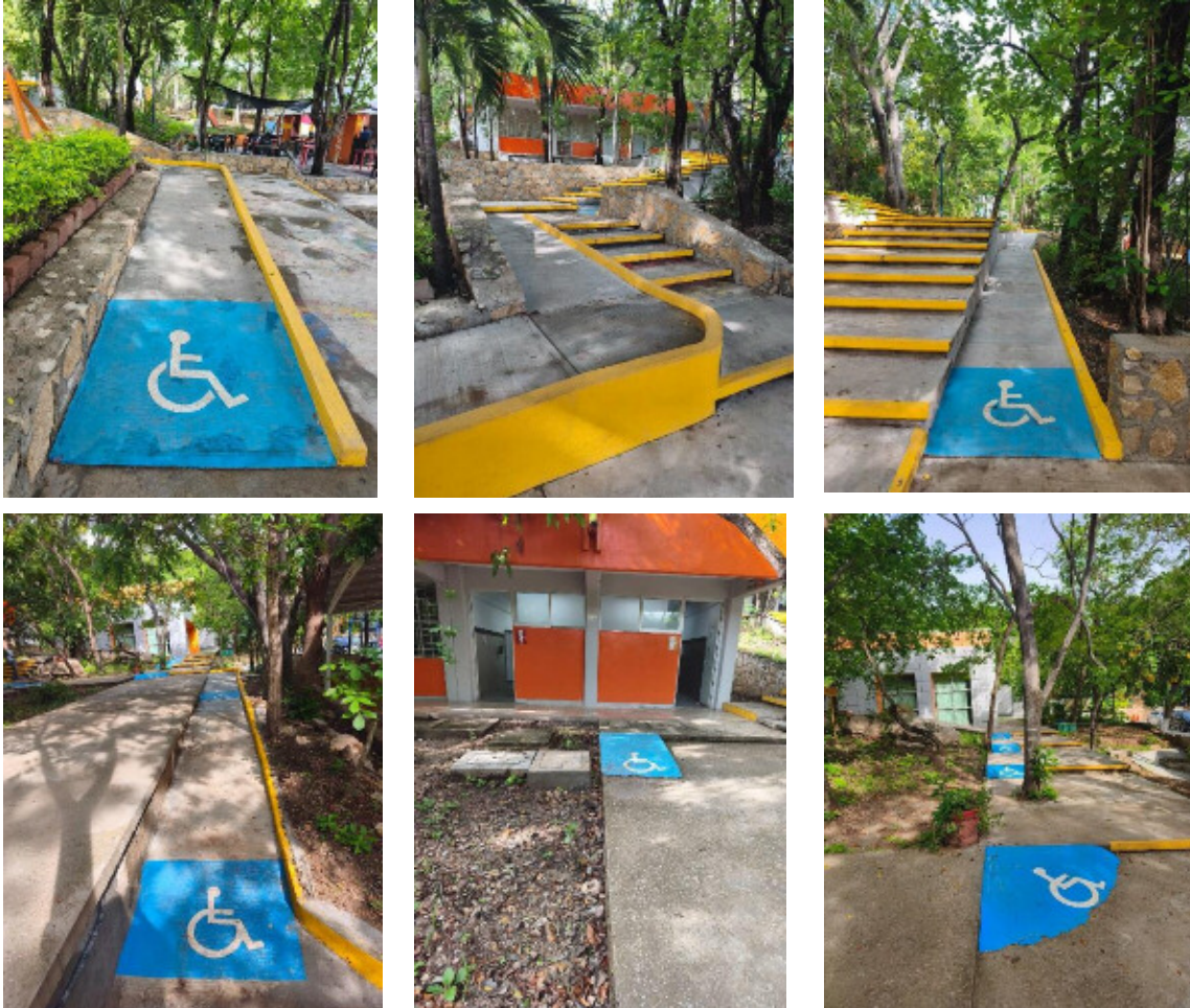
Rampa que une la plazoleta central con el edificio D y el aula polifuncional “Guillermo Díaz Peña”
