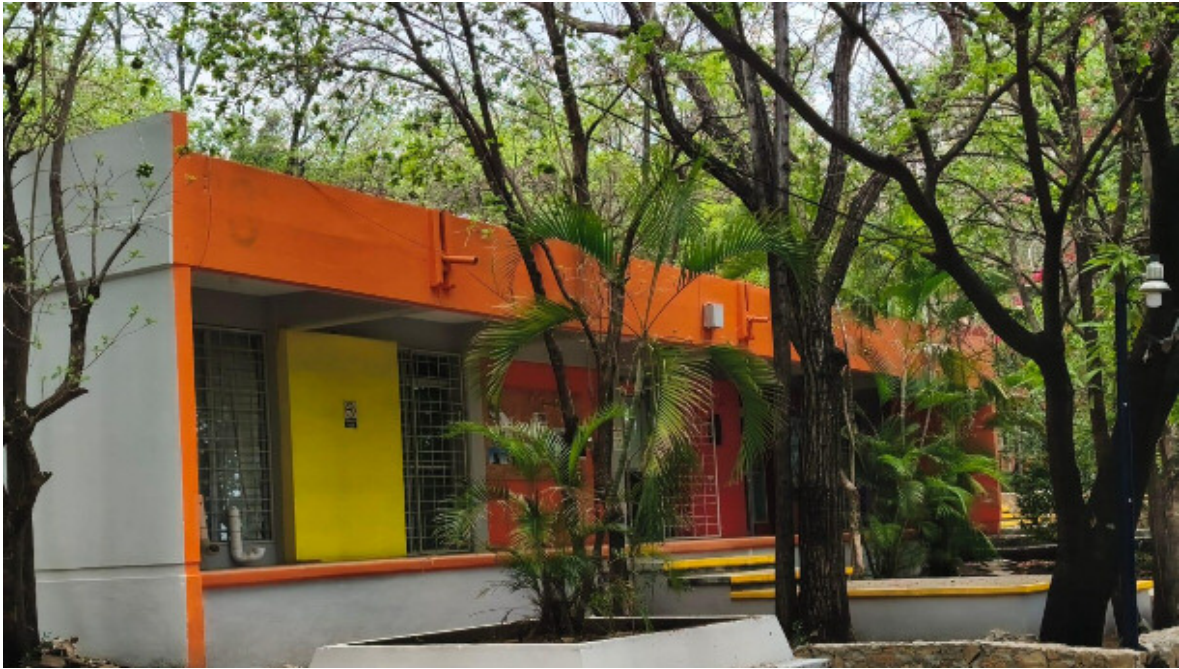
Imagen. Trabajos de pintura en el edificio C
