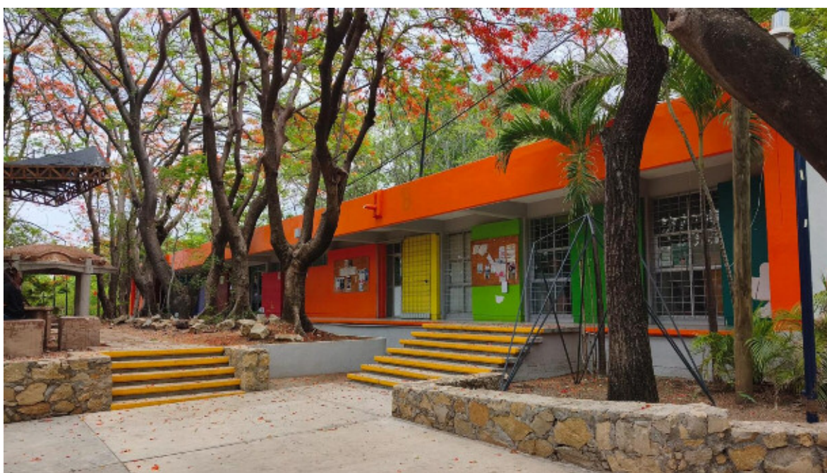
Imagen. Trabajos de pintura en el edificio B
