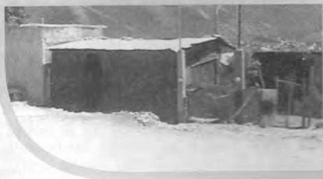
Fig. N° 10, Vivienda con techo de lámina de Zinc, similar a las casas donde vivían las familias antes del proyecto 10x10
