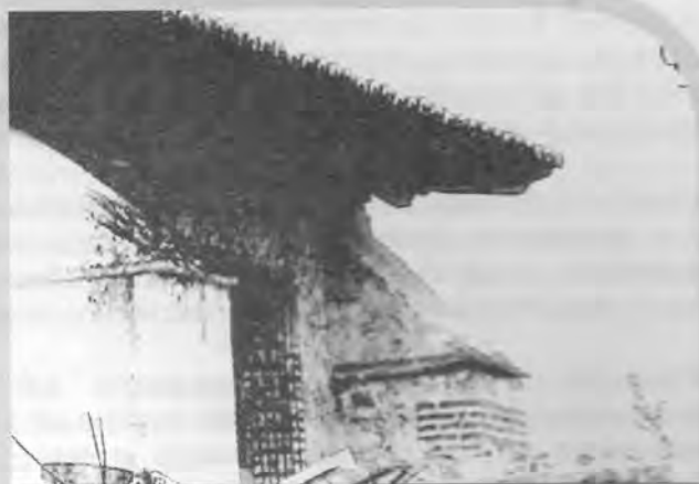
Contrafuerte de la Iglesia de San Francisco Foto F. Chanona
