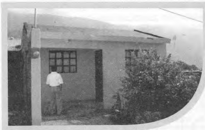
Fig. N°10 Vivienda techada con el sistema de techo Placa Losa
