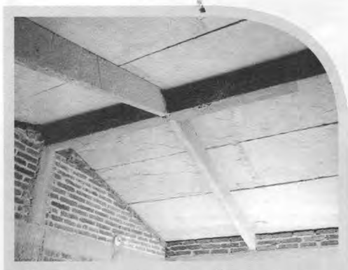
Fig. N°5. Interior de la vivienda techada con el sistema Placa-Losa en el Yuquis, antes de darle el acabado final, 2004.
