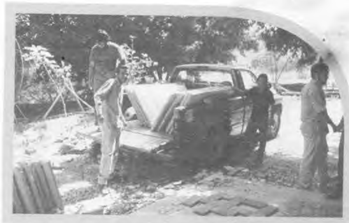
Fig. N°3. Placas prefabricadas en la FAUNACH, utilizadas en la construcción del techo para una de las casas del programa 10x10 Chiapas.
