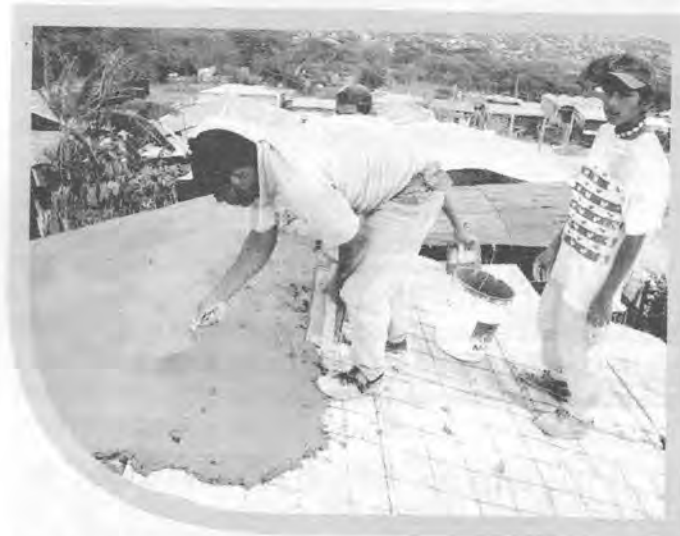
Fig. N°4. Construcción del sistema de techo Placa-Losa, en el fraccionamiento Yuquis en Tuxtla Gutiérrez, 2004.
